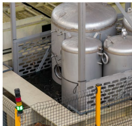
Decapaggio e passivazione a bagno.
